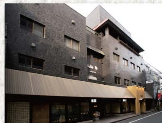
店舗南側外観
